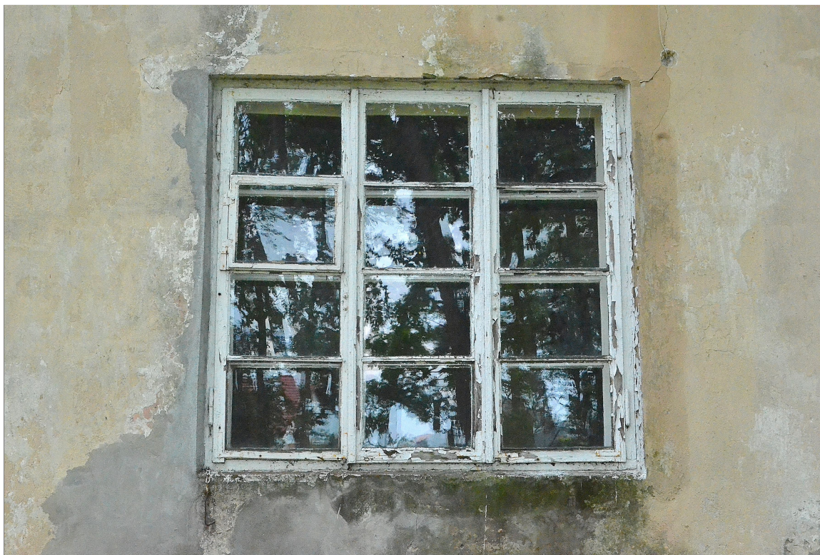
II. 18 Wieniec, tzw. Stary dwór – elewacja północna - widok na wtórną stolarkę okienną - awers
