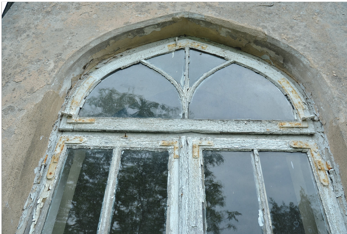
II. 27 Wieniec, tzw. Stary dwór – elewacja północna wieży - widok na pierwotną stolarkę okienną w III kondygnacji wieży (Faza I) - nadślepię
