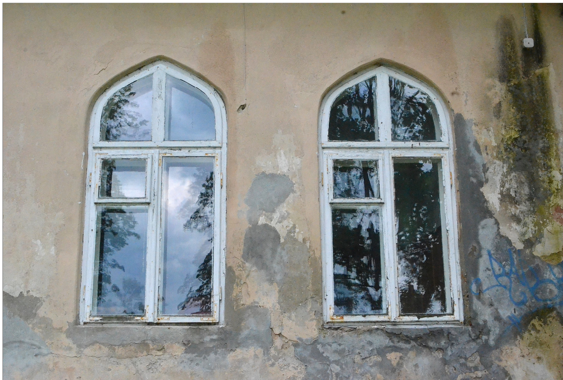
II. 13 Wieniec, tzw. Stary dwór – elewacja północna - widok na wtórną stolarkę okienną - awers
