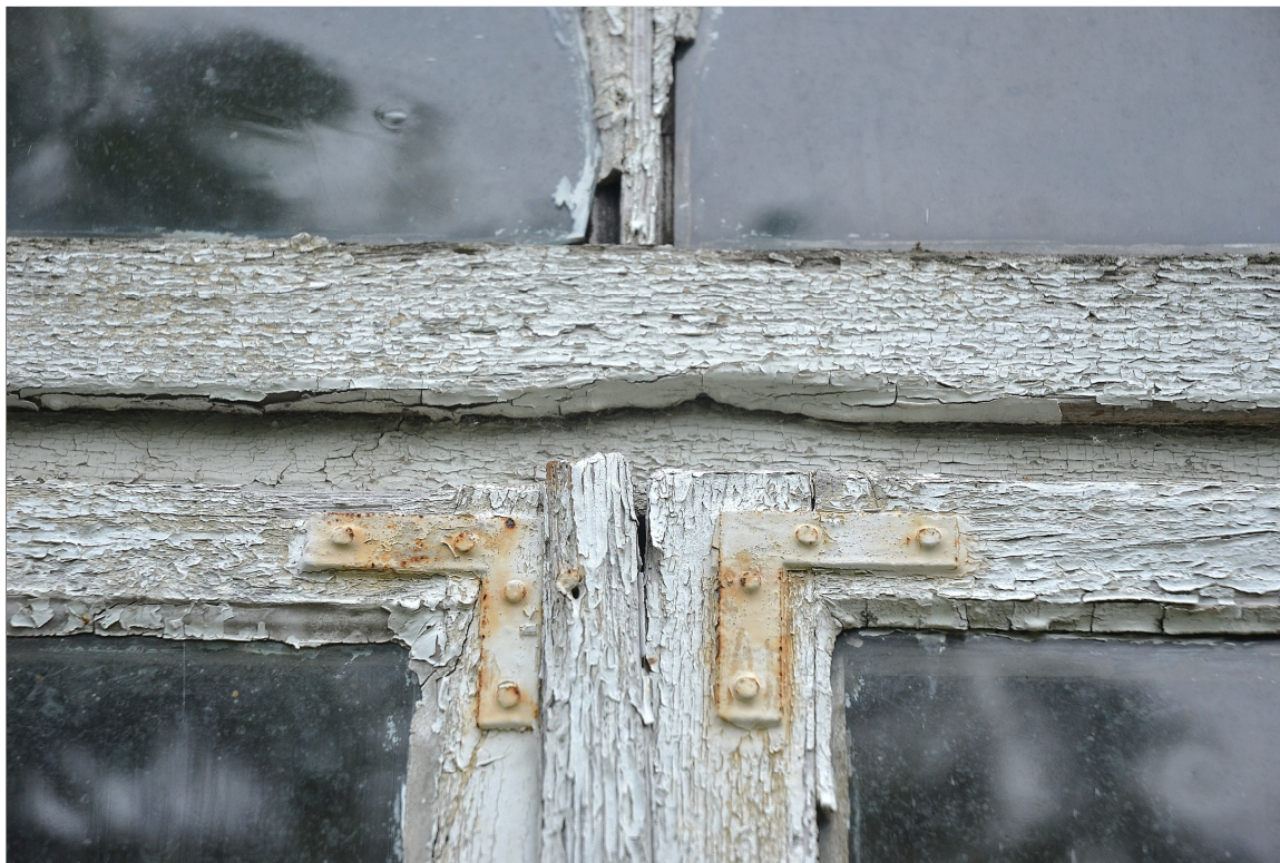
II. 29 Wieniec, tzw. Stary dwór – elewacja północna wieży - widok na pierwotną stolarkę okienną w III kondygnacji wieży (Faza I) - ślemię
