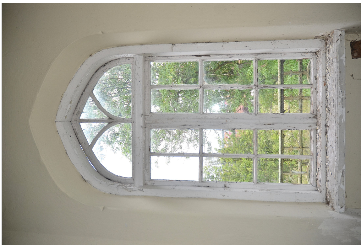
II. 26 Wieniec, tzw. Stary dwór – elewacja północna wieży - widok na pierwotną stolarkę okienną w III kondygnacji wieży (Faza I) - rewers
