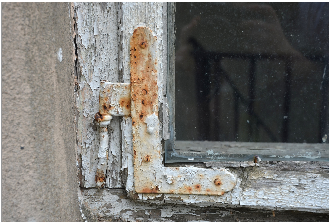
II. 30 Wieniec, tzw. Stary dwór – elewacja północna wieży - widok na pierwotną stolarkę okienną w III kondygnacji wieży (Faza I) – zawias hakowy kątowny
