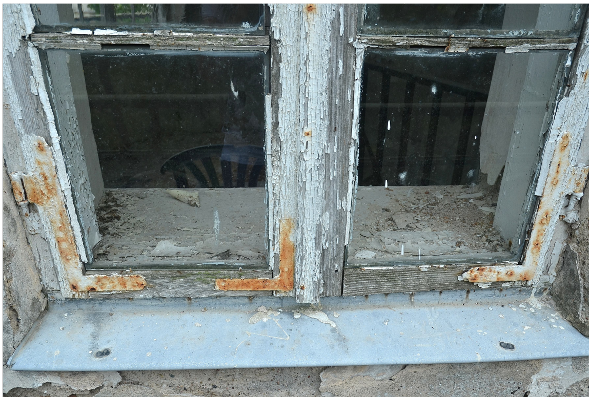
II. 28 Wieniec, tzw. Stary dwór – elewacja północna wieży - widok na pierwotną stolarkę okienną w III kondygnacji wieży (Faza I) - próg
