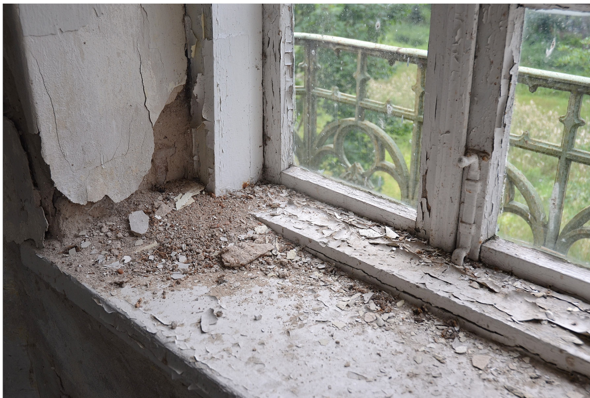
II. 34 Wieniec, tzw. Stary dwór – elewacja północna wieży - widok na pierwotną stolarkę okienną w III kondygnacji wieży (Faza I) - próg
