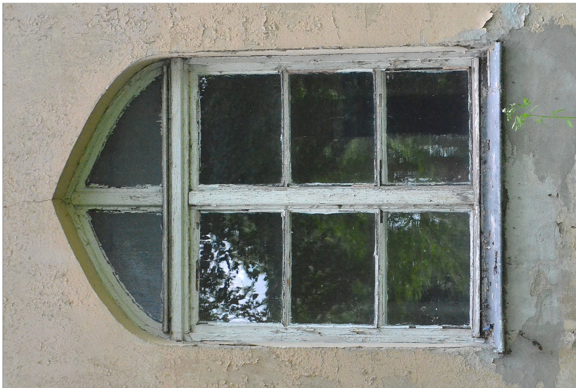
II. 19 Wieniec, tzw. Stary dwór – elewacja wschodnia przybudówki - widok na stolarzkę okienną skrzynkową - awers
